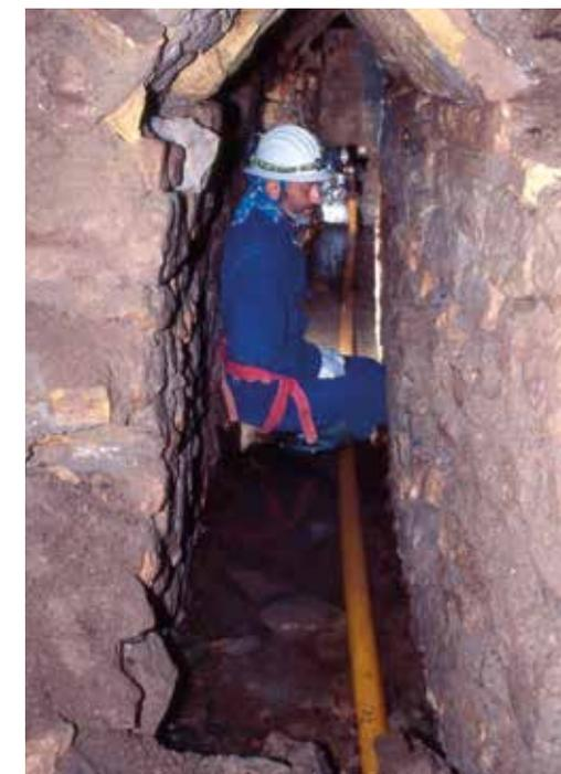
Particolare dell'interno del tratto voltato alla "cappuccina" del ramo captatore del settore ovest, Foto archivio G.S.P.
