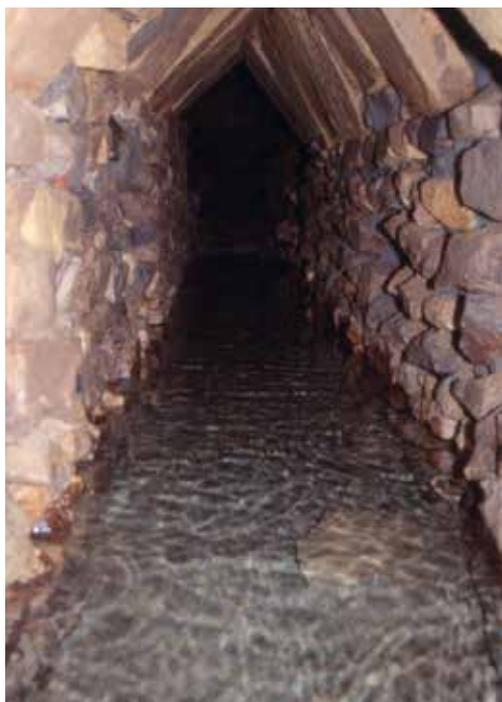
Particolare della parte interna del condotto voltato alla "cappuccina" nel settore centrale del collettore,
